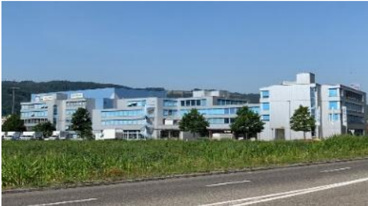
Spreitenbach (AG), Limmatstrasse 8-12
