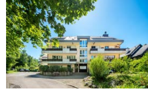
Zürich, Holderbachweg 21a
