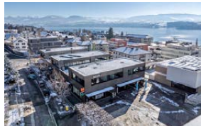
Männedorf, Alte Landstrasse 256 - 264
