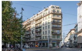
Genf, Rue des Deux-Ponts 18
