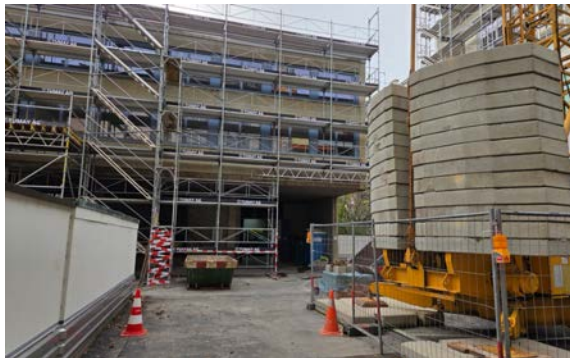
Baufortschritt Oktober 2025 Projekt «Stadtnest»
