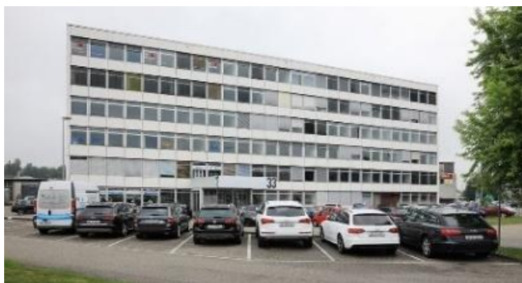
Langenthal (BE), Gaswerkstrasse 33-35
