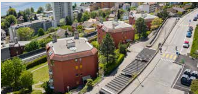
Neuchâtel, 24 bis 28, rue des Berthoudes
