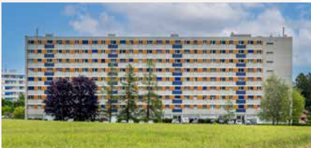
Nyon, 1 bis 7, rte du Reposoir
