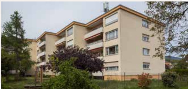
Peseux, 10/12, rue de la Gare
