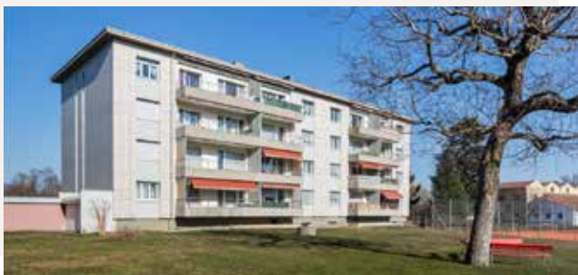
Cortailod, 6, 12/14. ch. des Landions
