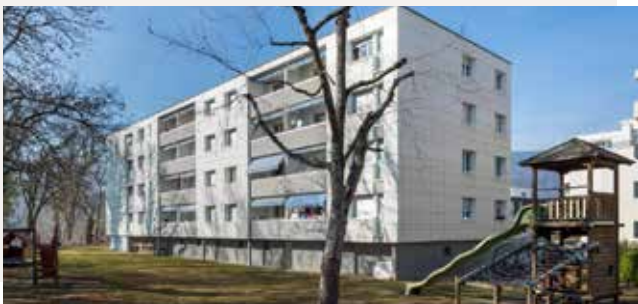
Boudry, 33/35, rte de la Gare
