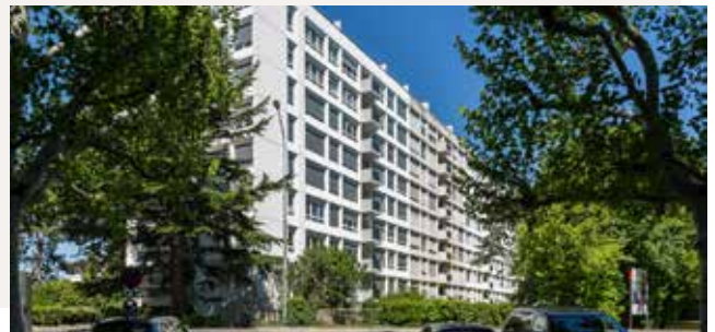
Onex, 103 et 91 à 95, av. Bois-de-la-Chapelle
