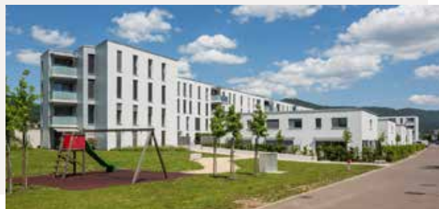
Delémont, 2, rue du Voirnet - 3/9/15/17, rue Emile Boéchat
