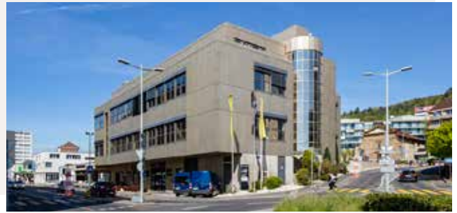
Neuchâtel, 39, rue de la Pierre-à-Mazel
