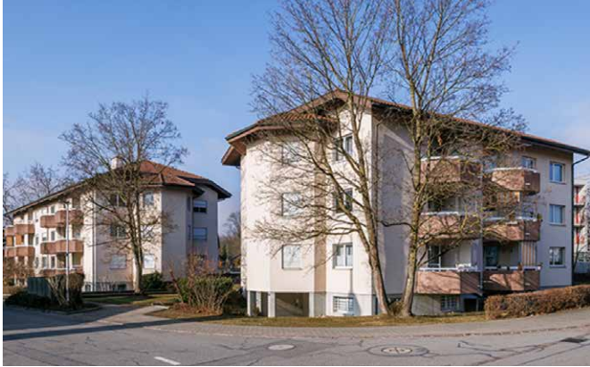
Aarau, Heuweg 3-7 Immeuble résidentiel
