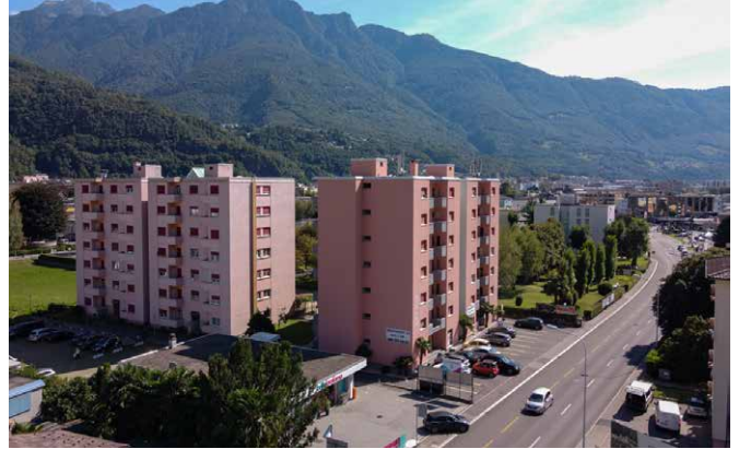
Bellinzona, Via Franco Zorzi 25/25A Immeuble résidentiel
