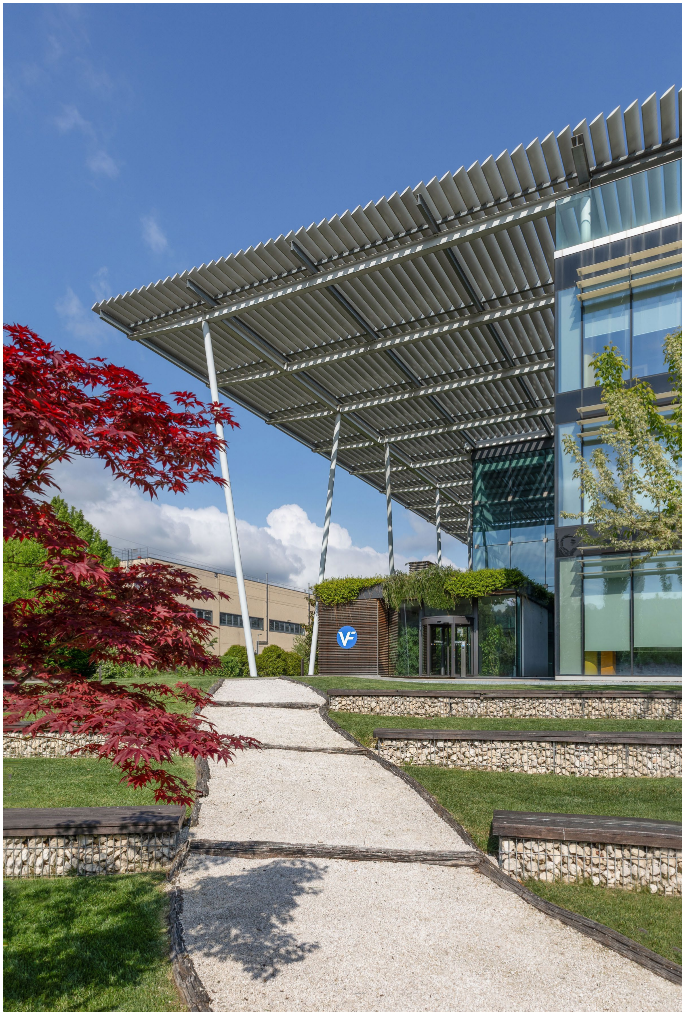
Foto: VF Corporation, Via Laveggio 4, Stabio
