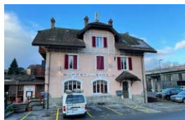
Lutry (VD) Route de la Conversion 289
