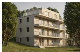
Pully (VD) Chemin de Ruisselet 16
