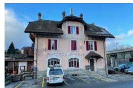
Lutry (VD) Route de la Conversion 289
