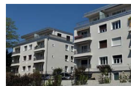
Pully (VD) Chemin de Ruisselet 18, 20, 22
