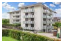
La Tour-de-Peilz (VD) Avenue de la Condémine 1
