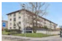
Le Grand-Saconnex (GE) 1 Chemin Alfred-Bétems 7
