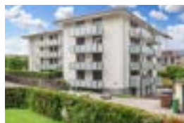
La Tour-de-Peilz (VD) Avenue de la Condémine 1
