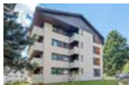
Corsier-sur-Vevey (VD) Sous-les-Terreux 1
