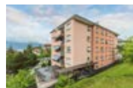
La Tour-de-Peilz (VD) Chemin des Murets 10
