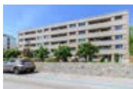
Neuchâtel (NE) Rue de Grise-Pierre 26, 28
