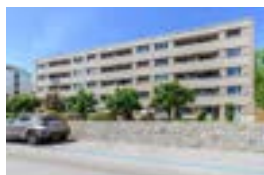
Neuchâtel (NE) Rue de Grise-Pierre 26, 28
