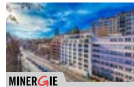
Lausanne (VD) 1 Rue de la Borde 17
