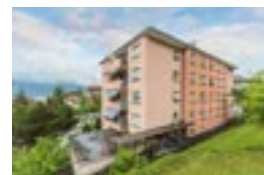
La Tour-de-Peilz (VD) Chemin des Murets 10
