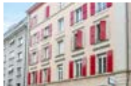
Lausanne (VD) Avenue de France 18bis
