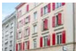
Lausanne (VD) Avenue de France 18bis
