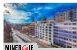
Lausanne (VD) 5 Rue de la Borde 17
