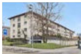
Le Grand-Saconnex (GE) 5 Chemin Alfred-Bétems 5, 7
