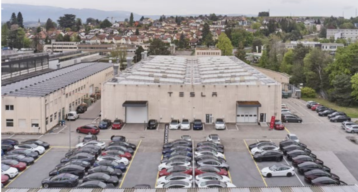
Boulevard de l'Arc-en-Ciel 28 et 42, Bussigny (VD)
